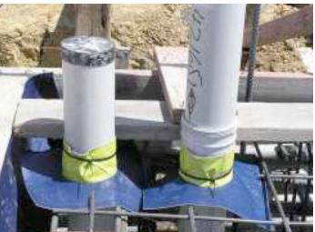
TERMIMESH est une **barrière PHYSIQUE** également sous avis technique (maille d'acier ultramarine inoxydable avec accessoire termistop autour des canalisations).
