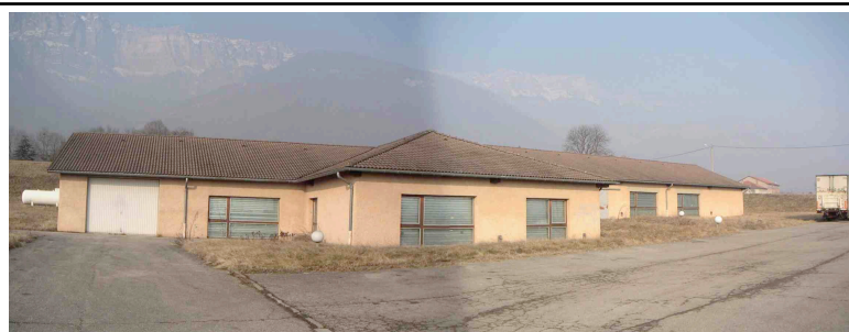
Bâtiment avant travaux
